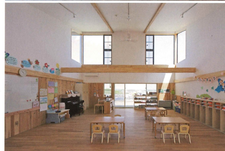
上：子育て支援室よりホールを見る。遊戯棟は扉を開けることで連続した大きな空間として使用可能。左下：保育室。保育棟は北側採光を得るため傾斜した屋根を持ち、天井高は約6m。 右下：ホール。屋根にはスパン長13.5mのキーラムメガビームを使用している。
