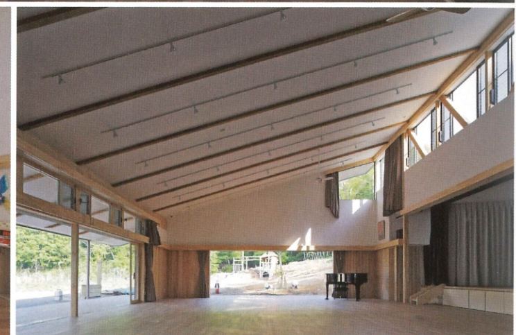
上：子育て支援室よりホールを見る。遊戯棟は扉を開けることで連続した大きな空間として使用可能。左下：保育室。保育棟は北側採光を得るため傾斜した屋根を持ち、天井高は約6m。 右下：ホール。屋根にはスパン長13.5mのキーラムメガビームを使用している。
